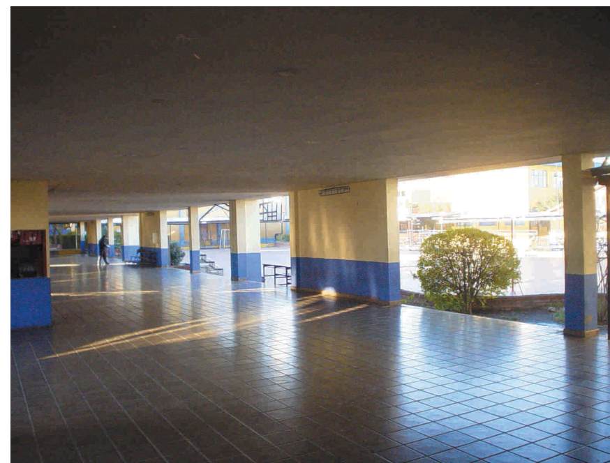
| Patio techado de los pabellones interiores inaugurados en 1965.
